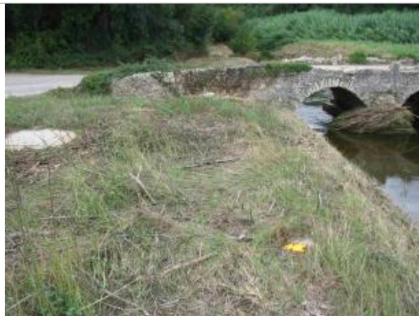
Vue du site - Auteur : Hydro Logik Ingénierie
