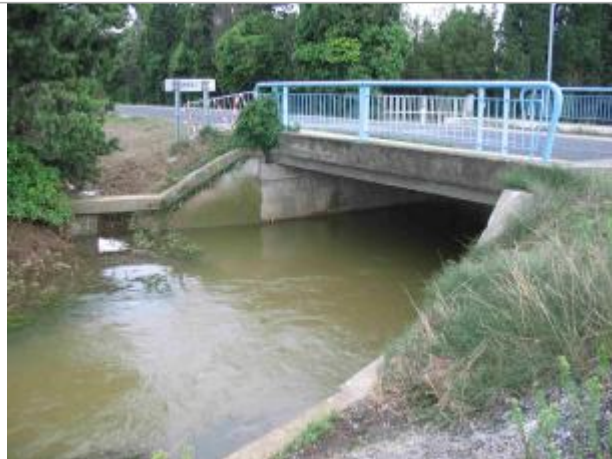
Vue du site - Auteur : Hydro Logik Ingénierie
