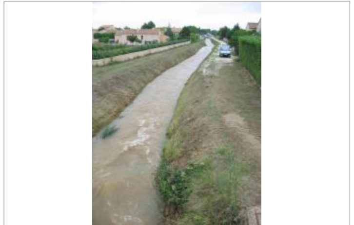
Vue du site - Auteur : Hydro Logik Ingénierie
