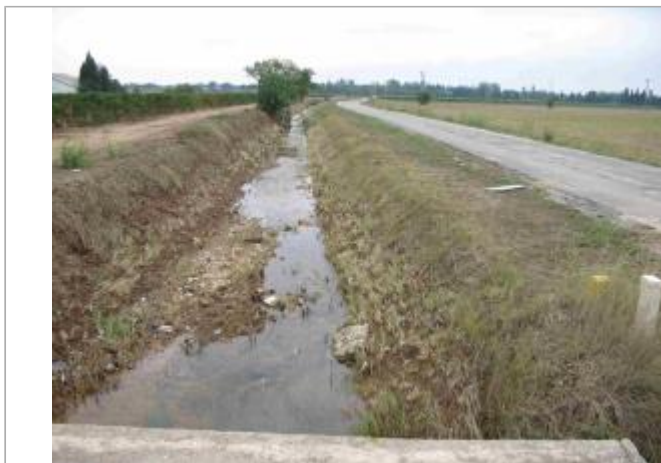
Vue du site - Auteur : Hydrologik Ingénierie
