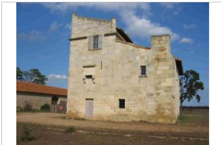
Vue du site - Auteur : Hydrologik Ingénierie
