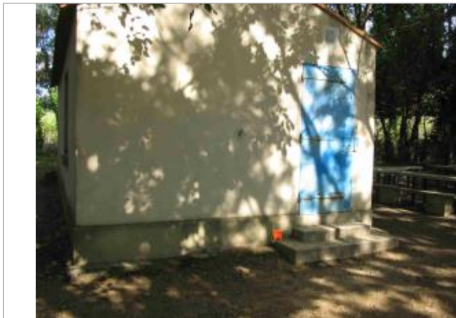
Vue du site - Auteur : Hydrologik Ingénierie
