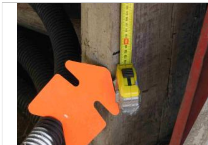
Photo du site - Auteur : Hydrologik Ingénierie
