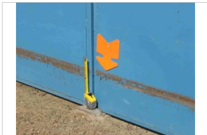
Photo du site - Auteur : Hydrologik Ingénierie
