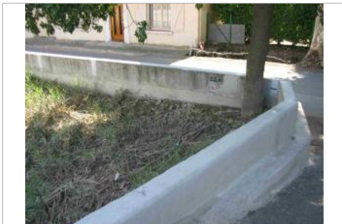
Vue du site - Auteur : Hydrologik Ingénierie
