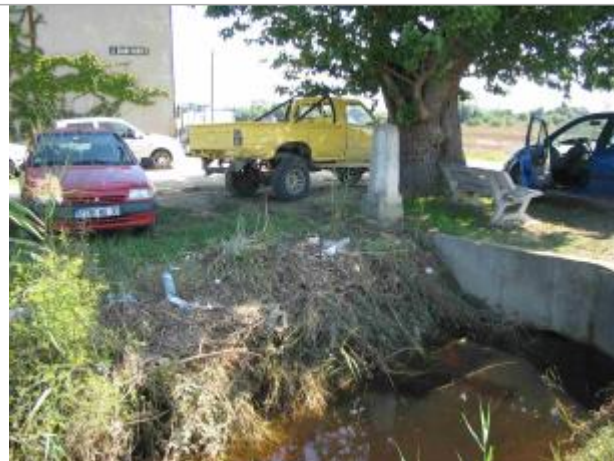
Vue du site - Auteur : Hydrologik Ingénierie
