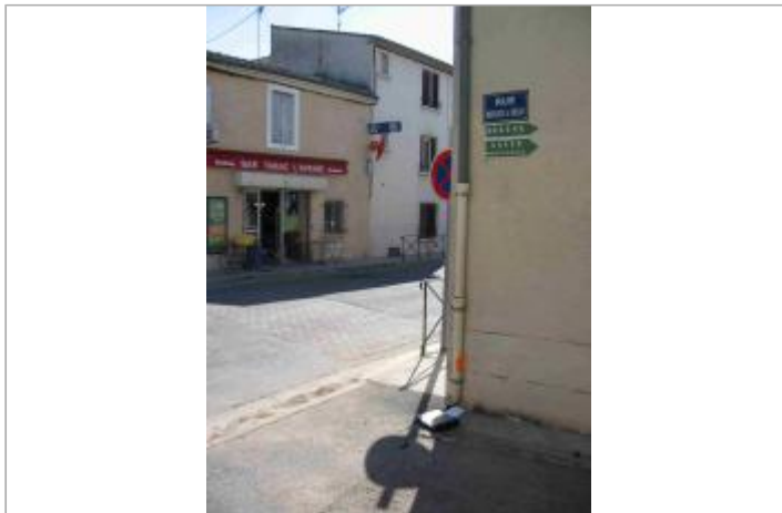
Vue du site - Auteur : Hydrologik Ingénierie
