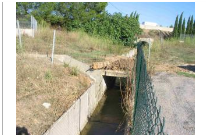
Vue du site - Auteur : Hydrologik Ingénierie
