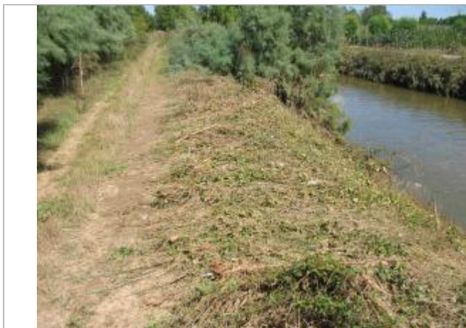
Vue du site - Auteur : Hydrologik Ingénierie
