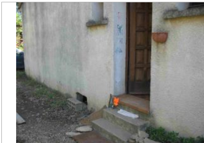
Vue du site - Auteur : Hydrologik Ingénierie
