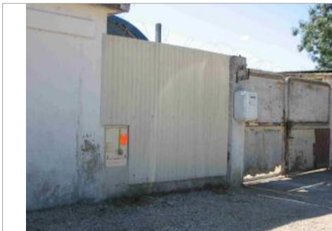
Vue du site - Auteur : Hydrologik Ingénierie
