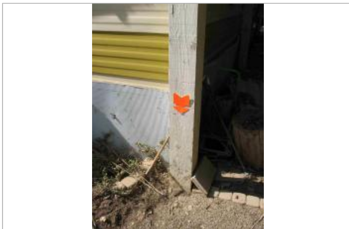
Vue du site - Auteur : Hydrologik Ingénierie
