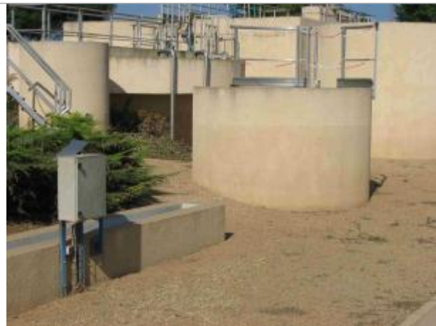
Vue du site - Auteur : Hydrologik Ingénierie
