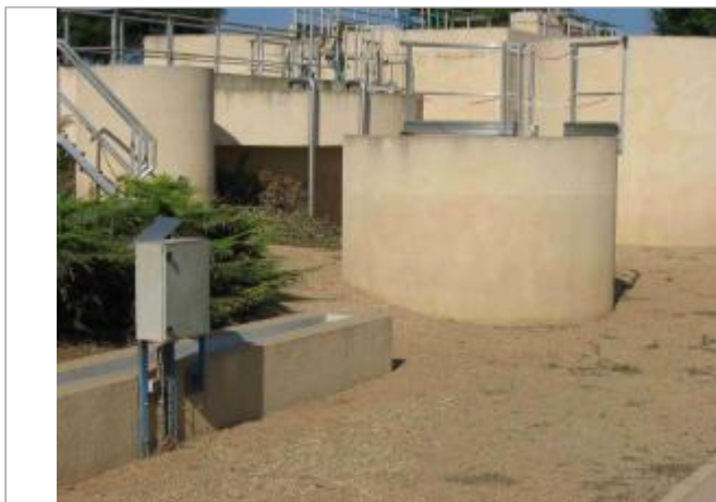
Vue du site - Auteur : Hydrologik Ingénierie
