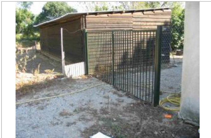
Vue du site - Auteur : Hydrologik Ingénierie
