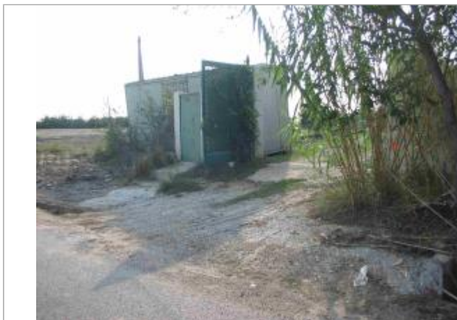
Vue du site - Auteur : Hydrologik Ingénierie
