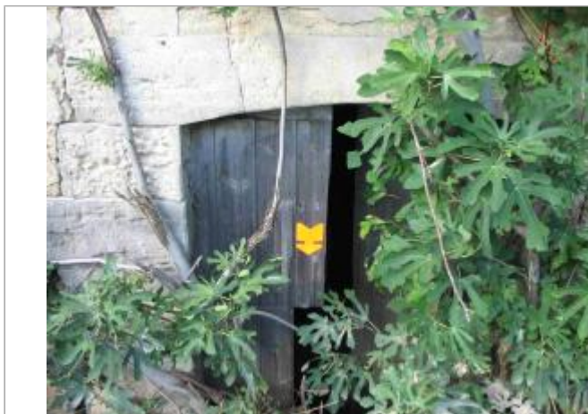
Vue du site - Auteur : Hydrologik Ingénierie
