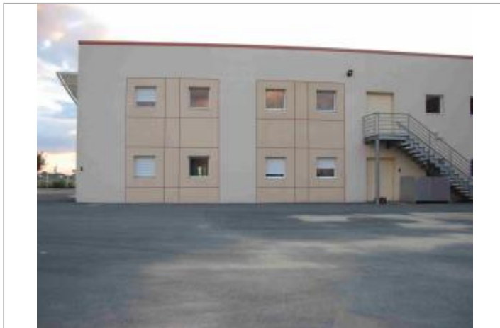
Vue du site - Auteur : Hydrologik Ingénierie
