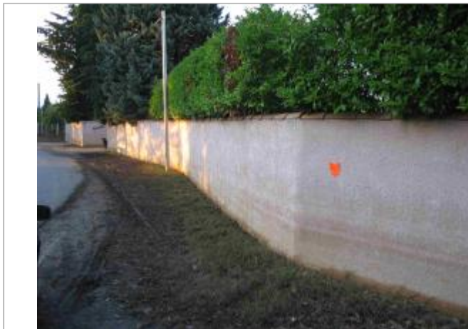
Vue du site - Auteur : Hydrologik Ingénierie
