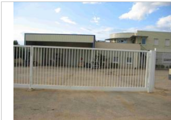
Vue du site - Auteur : Hydrologik Ingénierie
