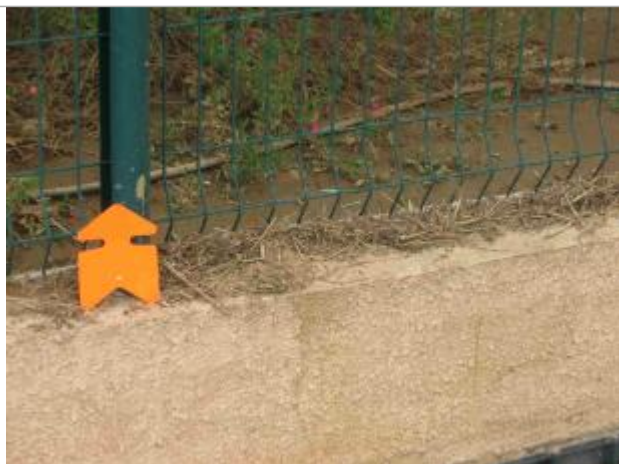
Photo du site - Auteur : Hydrologik Ingénierie
