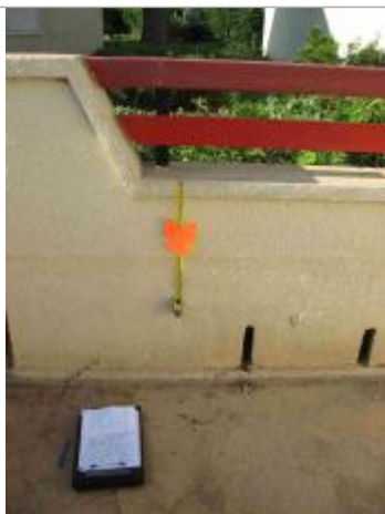
Photo du site - Auteur : Hydrologik Ingénierie
