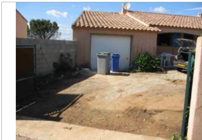
Vue du site - Auteur : Hydrologik Ingénierie
