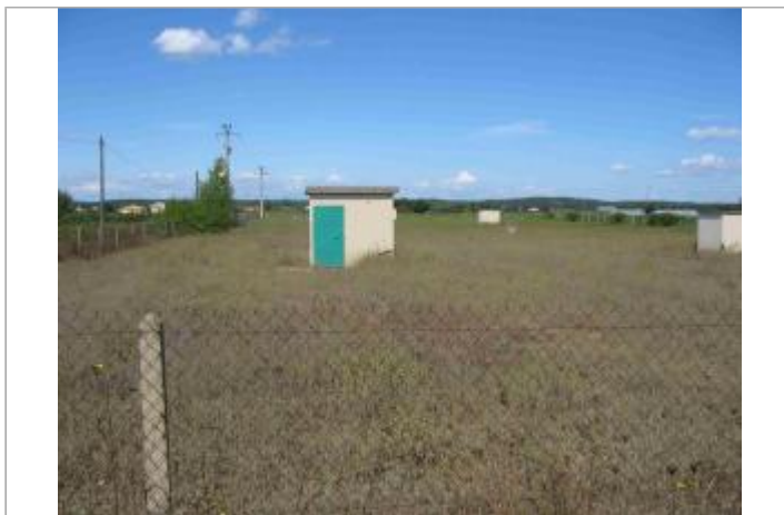
Vue du site - Auteur : Hydrologik Ingénierie
