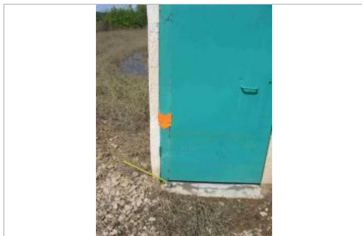
Photo du site - Auteur : Hydrologik Ingénierie
