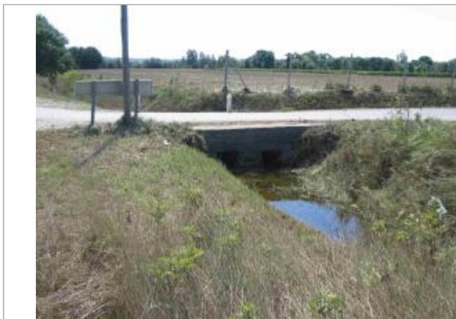
Vue du site - Auteur : Hydrologik Ingénierie
