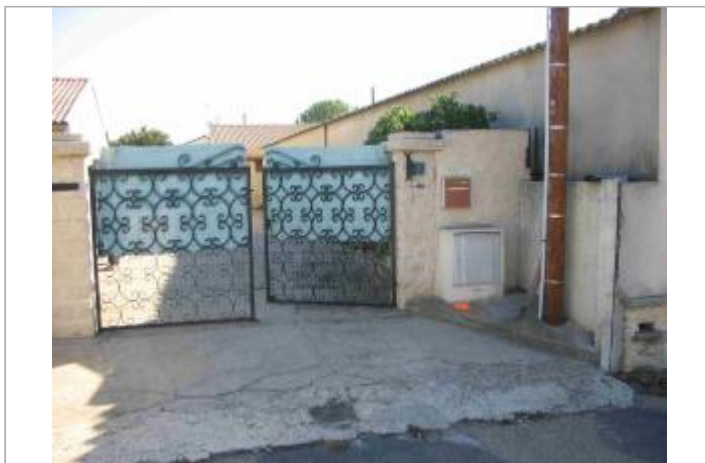
Vue du site - Auteur : Hydrologik Ingénierie
