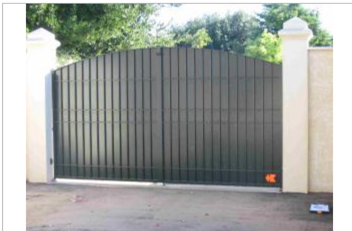
Vue du site - Auteur : Hydrologik Ingénierie
