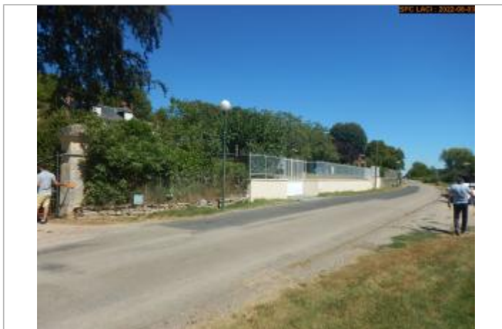
Vue du site éloignée
