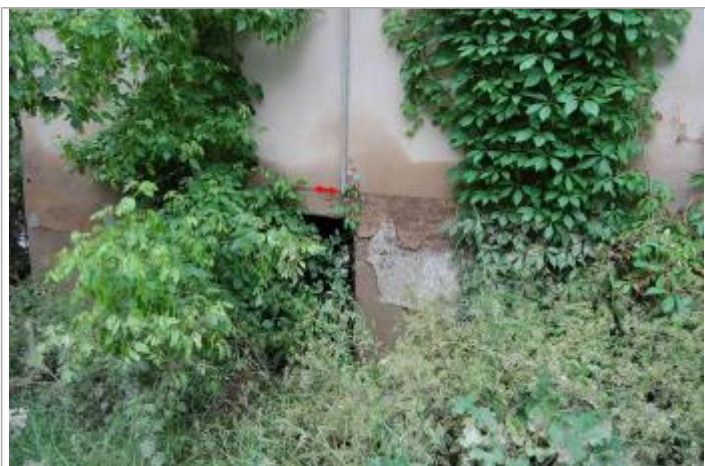
Vue du repère - Géosphair
