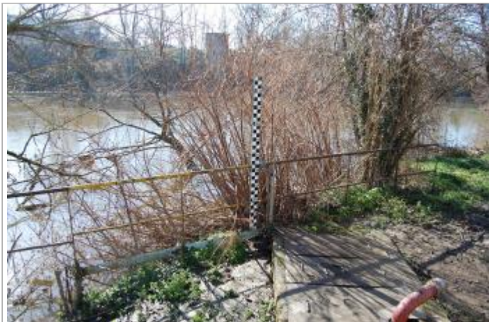
Vue du l'échelle
