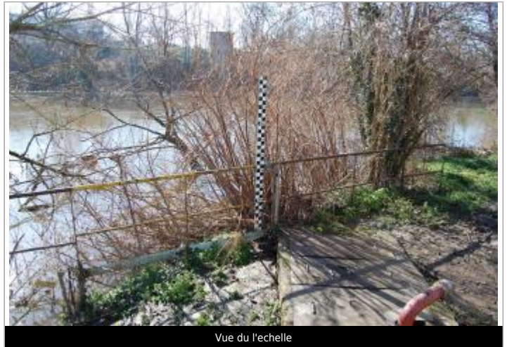
Vue du l'échelle
