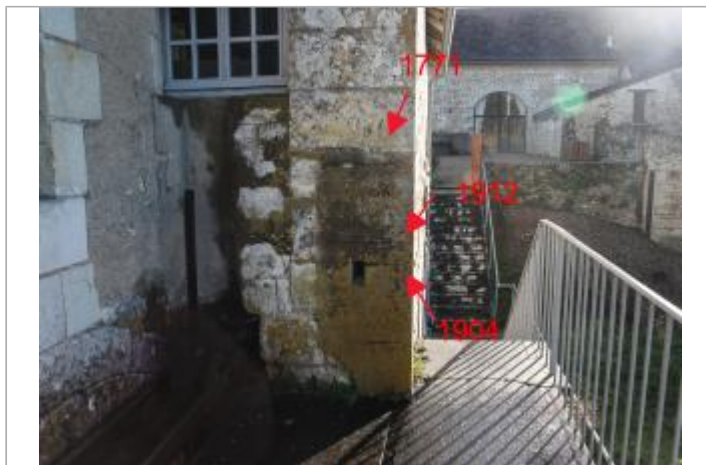
Mur pignon Ouest - face rivière
