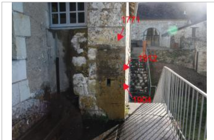
Mur pignon Ouest - face rivière
