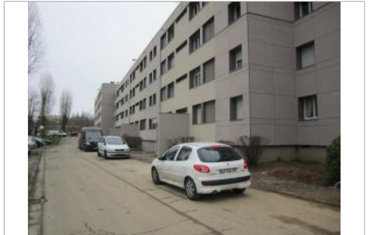
Vue d'ensemble avenue de Limburg
