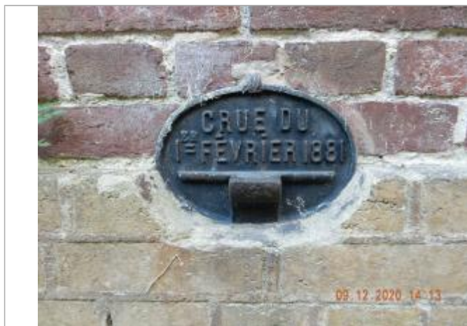
Plaque de la crue du 1 février 1881
