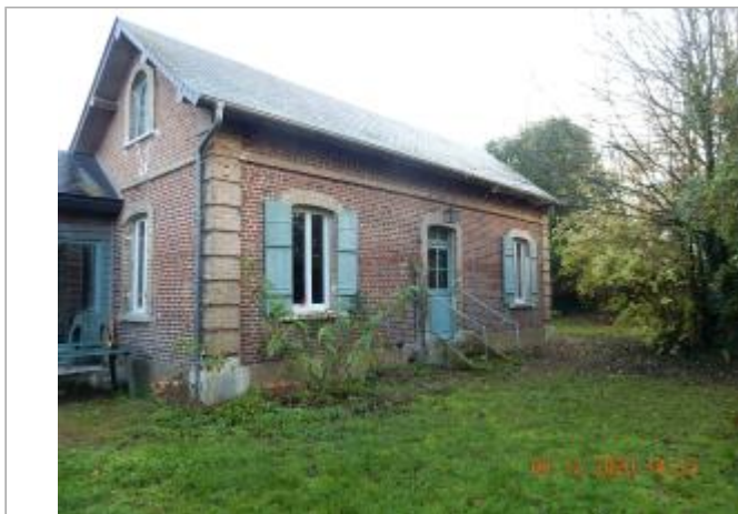
Maison de l'éclusier
