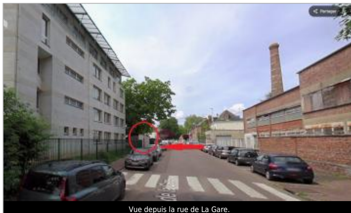
Vue depuis la rue de La Gare.
