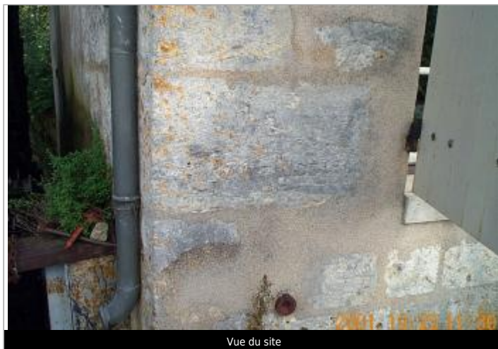
Vue du site
