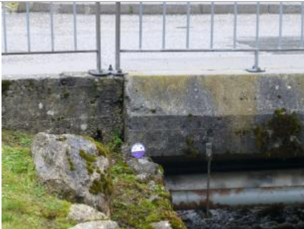
SUR LE TABLIER DU PONT
