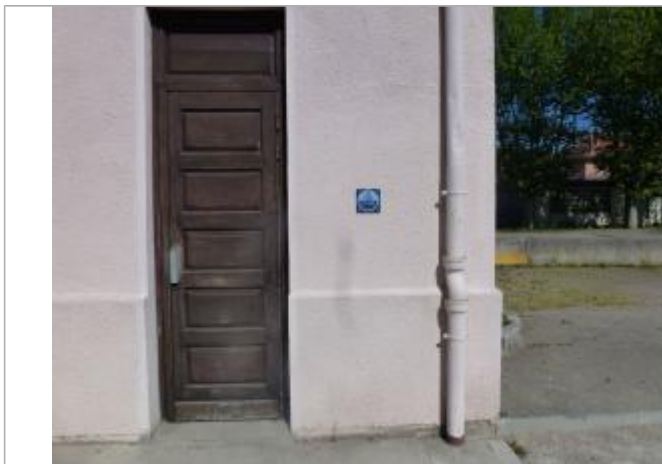
Repère de la crue du 2 décembre 2003 sur le mur de la salle Servanin.
