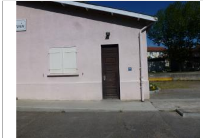
Repère de la crue de 2003 sur le mur de la salle Servanin
