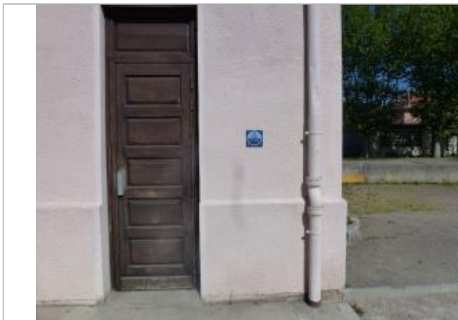
Repère de la crue du 2 décembre 2003 sur le mur de la salle Servanin.
