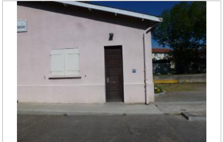
Repère de la crue de 2003 sur le mur de la salle Servanin
