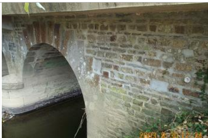
Photo des repères de crue et de nivellement IGN en 2003
