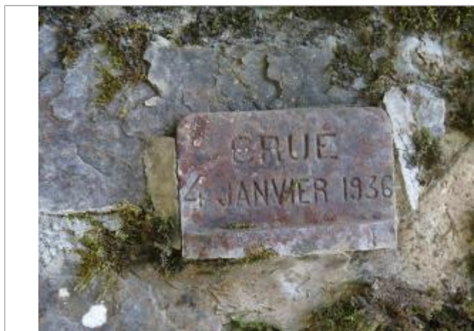
repere de crues lors la visite du SPC VCB le 17 octobre 2018
