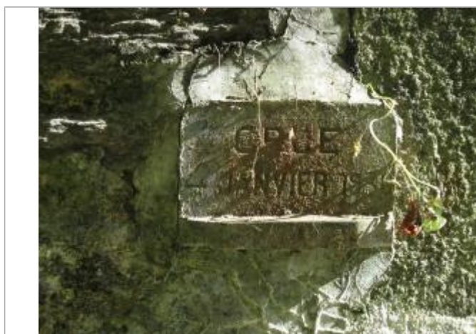
repère de crue sous le pont de la RD92
