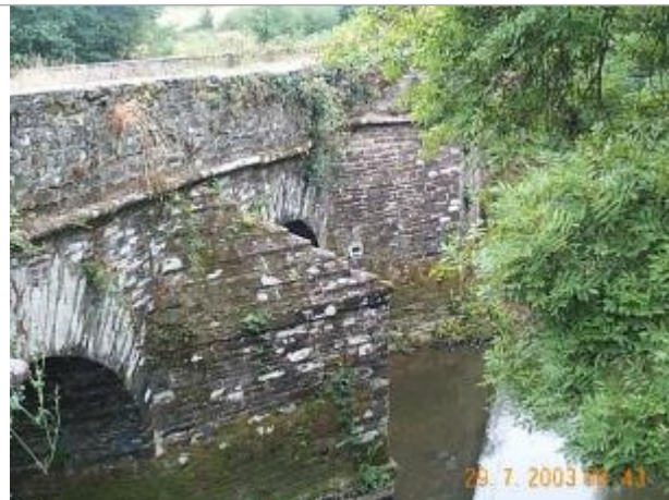
Pont de Lassy à Guignen
