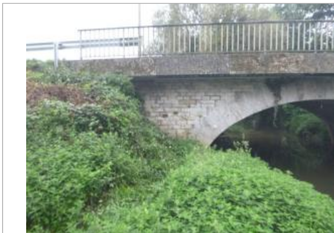
Vue du site amont du pont
