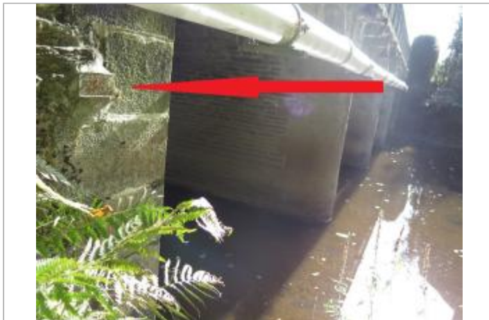
vue du site sous le pont de la RD92
