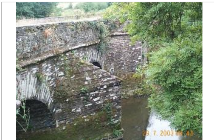
Pont de Lassy à Guignen
