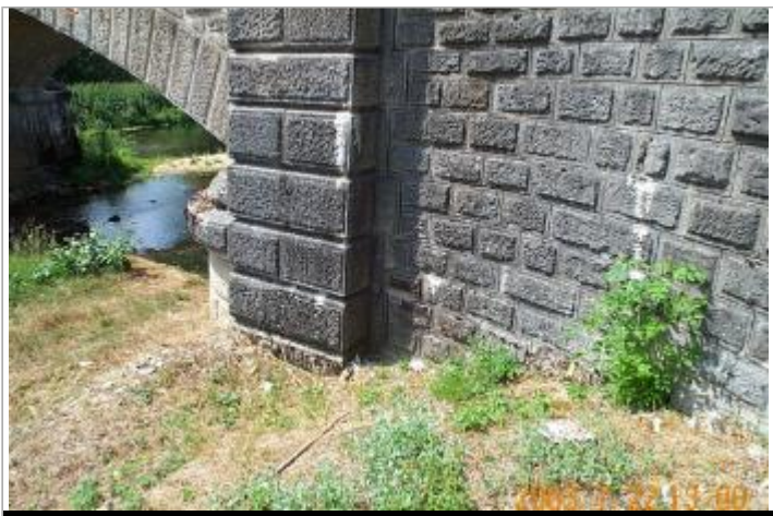
Vue du site
